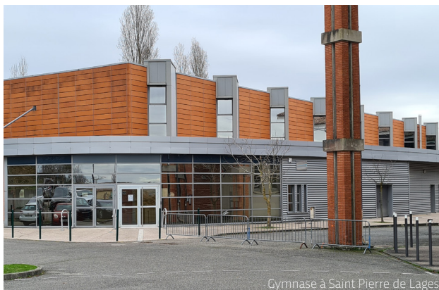
Gymnase à Saint Pierre de Lages
