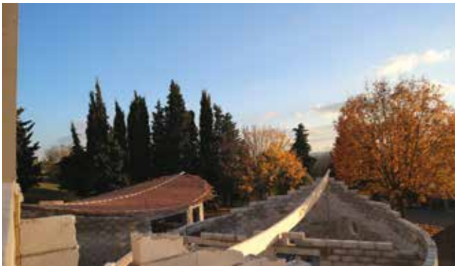
Construction d'une nouvelle crèche à Caraman - Décembre 2017
