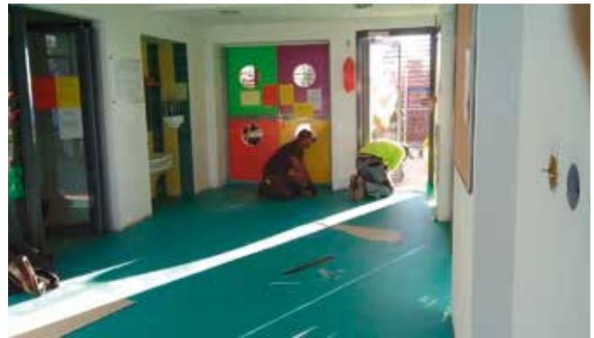
Travaux à la crèche des K'Nailloux - Décembre 2017
