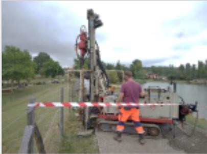
Dans le cadre du suivi du barrage, **3 piézomètres étaient défectueux**, la société Temsol a procédé au **remplacement** de ces derniers afin de poursuivre les suivis mensuels de l'ouvrage. Également présente, la DREAL avec son regard averti, dans le cadre des vérifications de mise en conformité de l'ouvrage.
