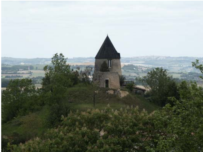
Moulin réhabilité à St Félix
